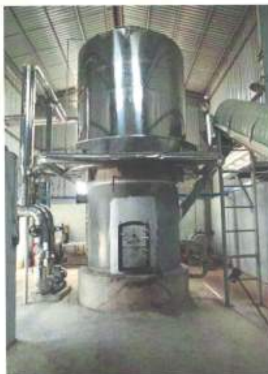
Lò dầu tải nhiệt dùng Biomass
